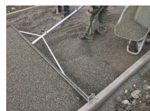
Bordure de chaque côté Les roulettes latérales posées sur les 2 bordures facilitent le dégagement de gravillon superflu
