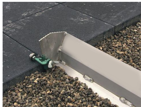
Bordure de chaque côté Les roulettes latérales posées sur les 2 bordures facilitent le dégagement de gravillon superflu
